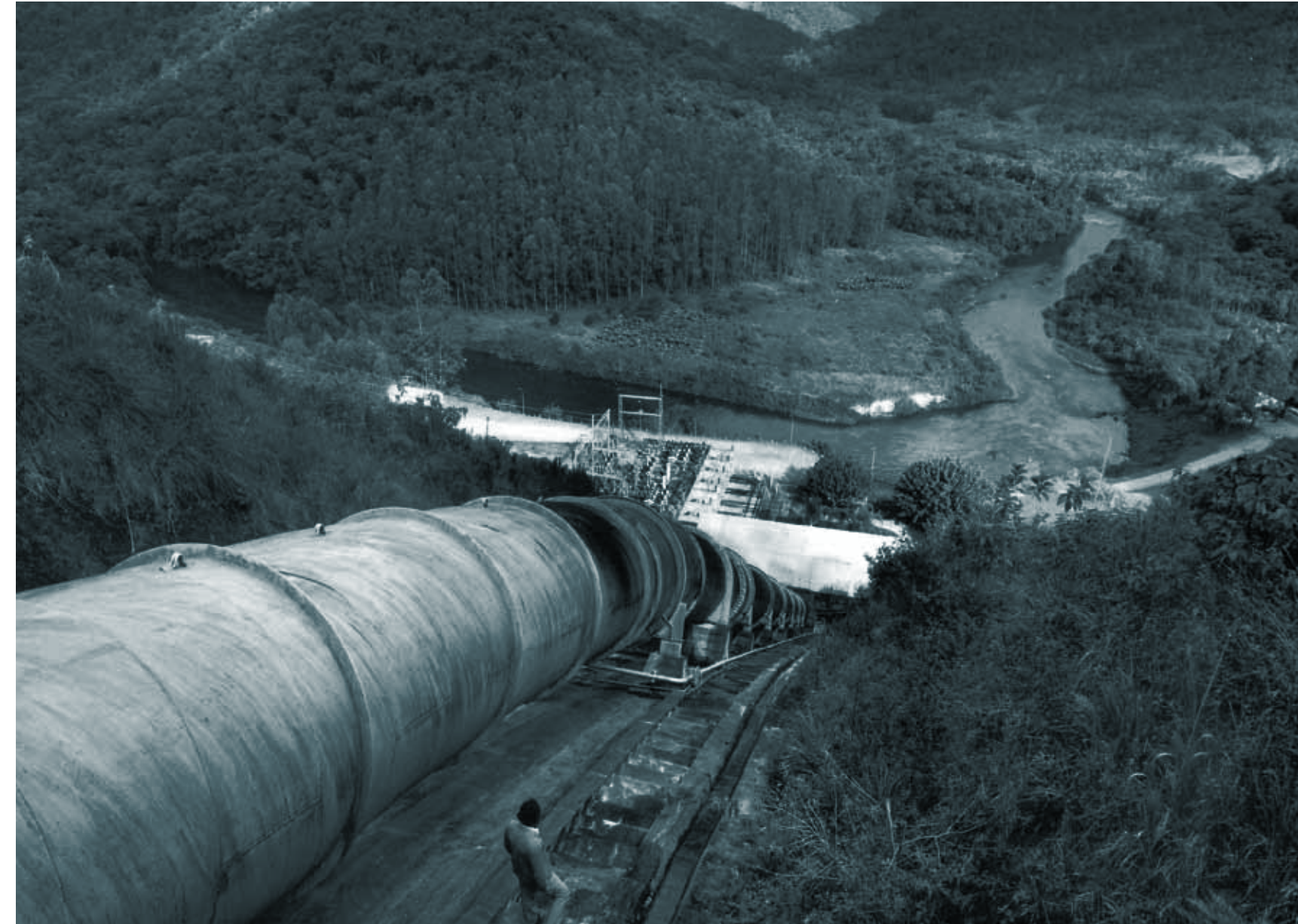
▲ Vista dos dutos da usina em construção. Usina da Fumaça (anos 1950)
